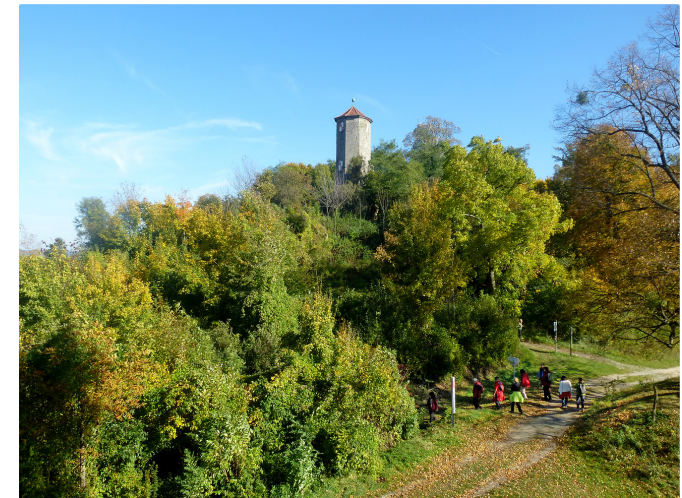
Treppenturm des Alten Schlosses (19.10.2013, VGN © VGN GmbH)
