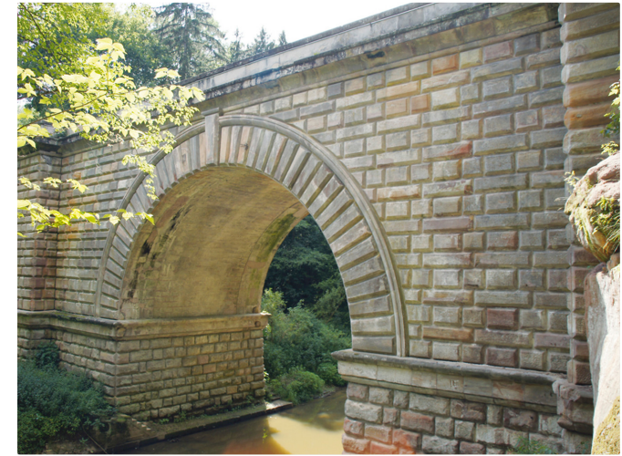
Trogbrücke Brückkanal – Oben Kanal, unten Schwarzach (10.07.2011, VGN © VGN GmbH)
